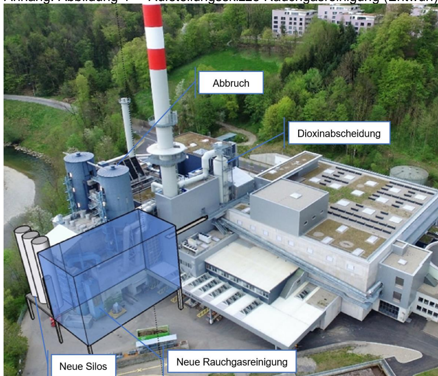
Anhang: Abbildung 4 – Aufstellungsskizze Rauchgasreinigung (Entwurf)
